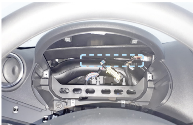
Фото 2.10 Пример расположения центрального блока охранно-телематического комплекса
