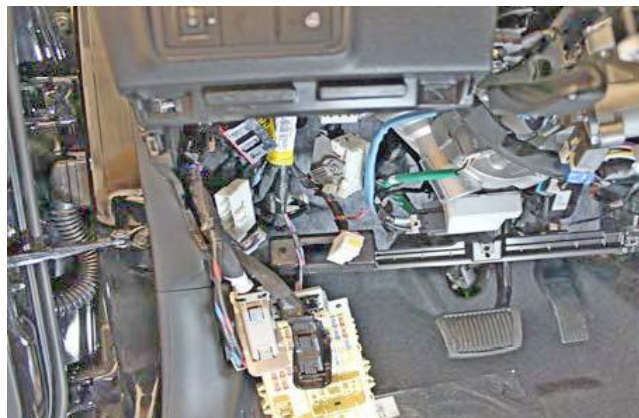
Фото 1.8. Монтажный блок предохранителей снят
