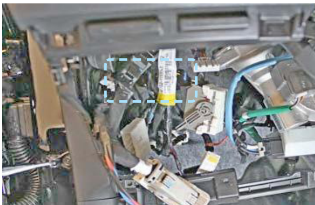
Фото 2.8. Пример расположения центрального блока охранно-телематического комплекса
