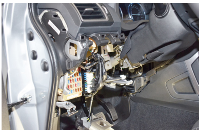
Фото 1.7. Пластиковая накладка под рулевой колонкой снята
