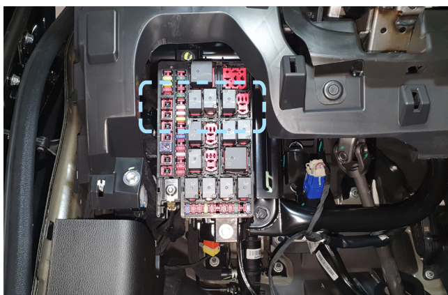
Фото 2.8. Пример расположения центрального блока охранно-телематического комплекса
