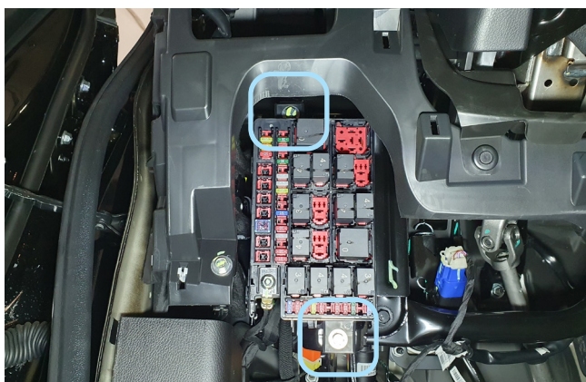
Фото 1.5. Болты крепления монтажного блока предохранителей
