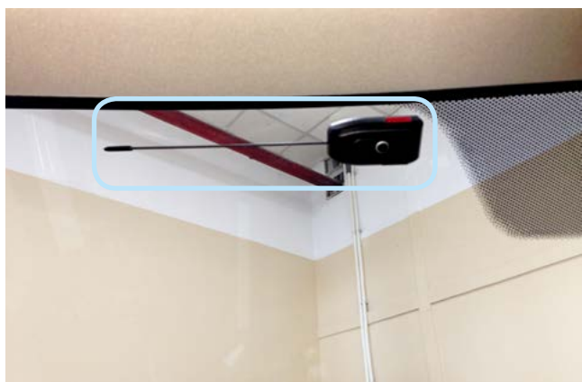
Фото 2.1. Возможное место установки антенного модуля
