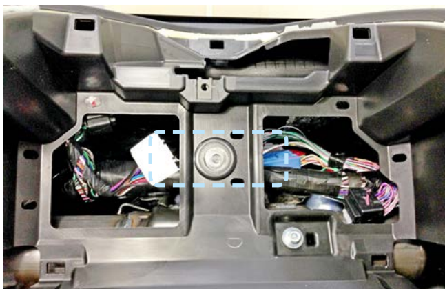
Фото 2.9. Пример расположения центрального блока охранно-телематического комплекса
