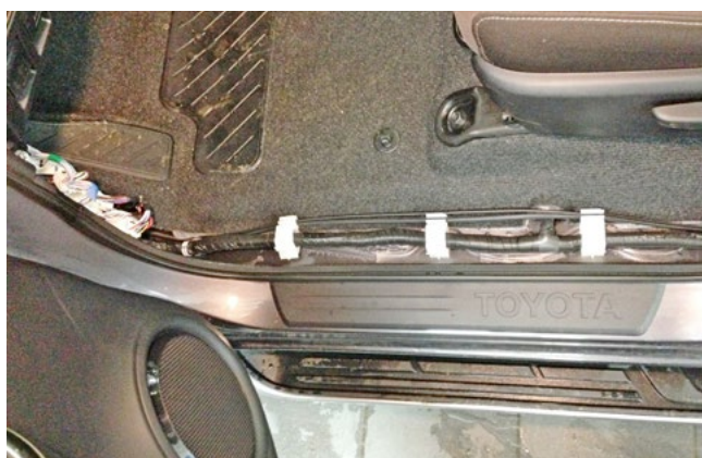
Фото 1.3. Накладки порога и кик-панели сняты
