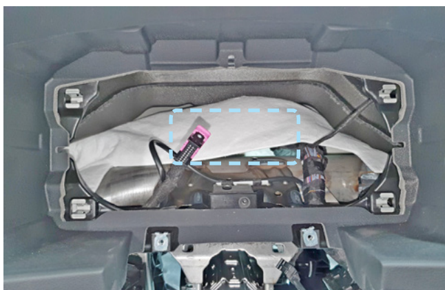
Фото 2.7. Пример расположения центрального блока охранно-телематического комплекса
