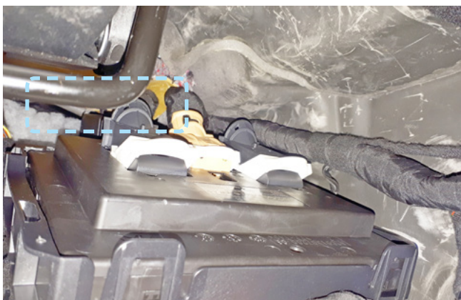
Фото 2.10. Пример расположения центрального блока охранно-телематического комплекса
