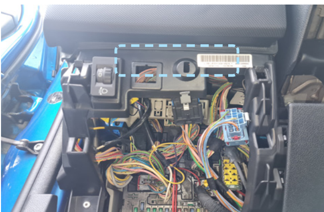
Фото 2.8. Пример расположения центрального блока охранно-телематического комплекса
