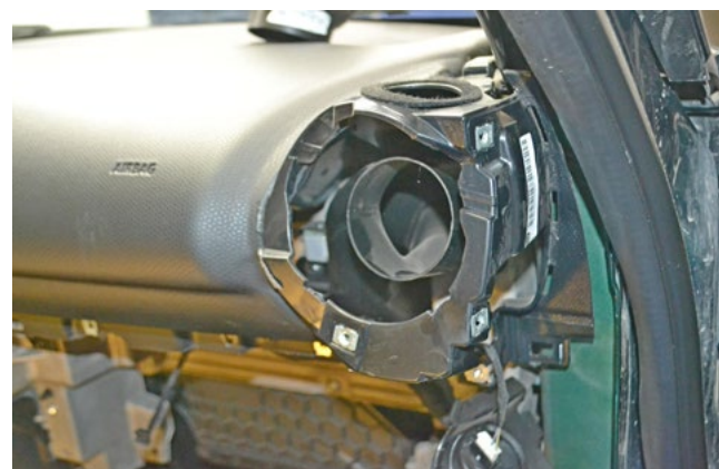
Фото 1.22. Накладка правого воздуховода снята
