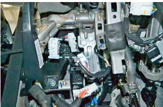
Фото 2.7. Пример расположения центрального блока охранно-телематического комплекса
