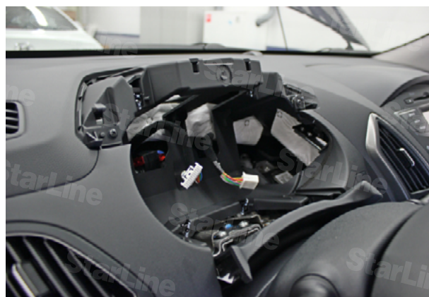
Фото 2.6. Комбинация приборов снята
