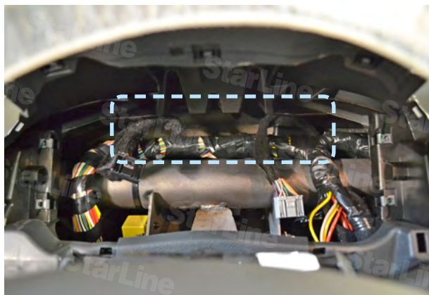
Фото 5. Пример расположения центрального блока охранно-телематического комплекса
