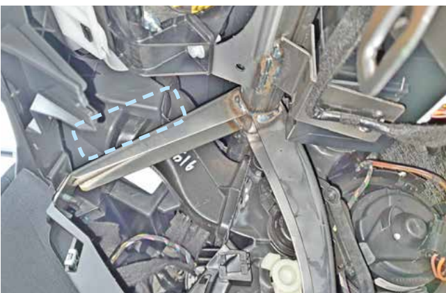
Фото 2.7. Пример расположения центрального блока охранно-телематического комплекса
