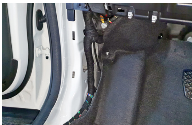
Фото 1.9. Накладка левой кик-панели снята
