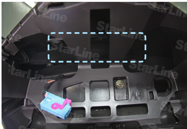
Фото 5. Пример расположения центрального блока охранно-телематического комплекса
