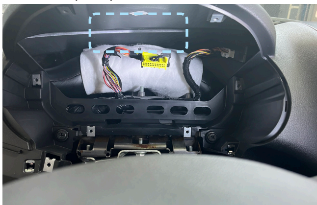
Фото 2.8. Пример расположения центрального блока охранно-телематического комплекса
