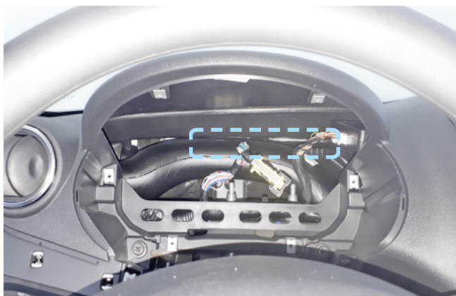
Фото 2.10. Пример расположения центрального блока охранно-телематического комплекса
