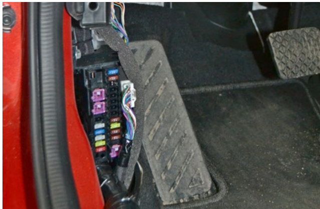
Фото 1.4. Пластиковая накладка левой кик-панели снята
