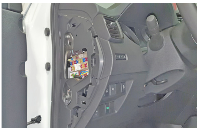
Фото 1.3. Боковая накладка передней панели снята
