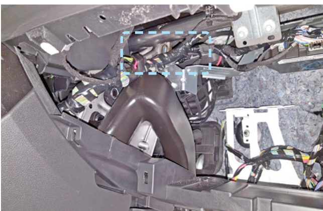
Фото 2.8. Пример расположения центрального блока охранно-телематического комплекса
