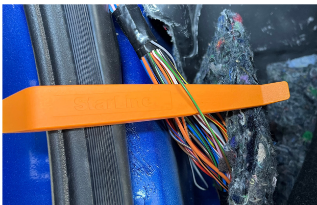
Фото 3.6. Концевик водительской двери (коричнево-зелёный, подключить при отсутствии коричнево-красного провода)
