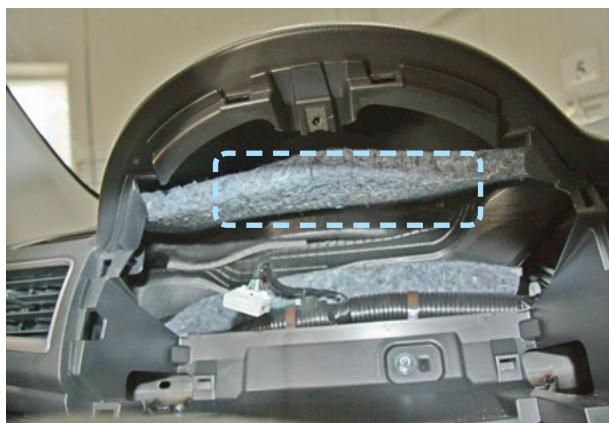
Фото 2.7. Пример расположения центрального блока охранно-телематического комплекса
