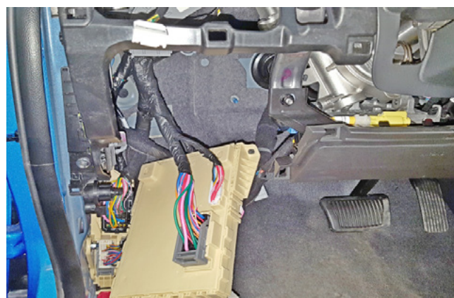
Фото 1.24. Монтажный блок предохранителей снят
