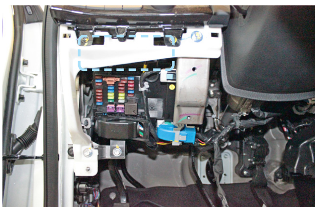
Фото 2.6. Пример расположения центрального блока охранно-телематического комплекса
