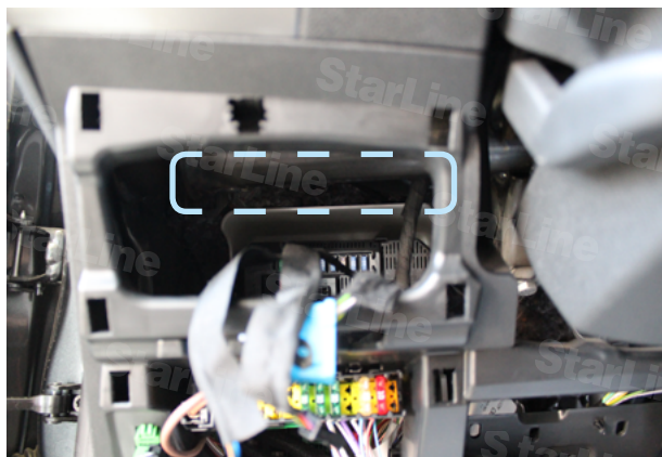
Фото 6. Пример расположения центрального блока охранно-телематического комплекса
