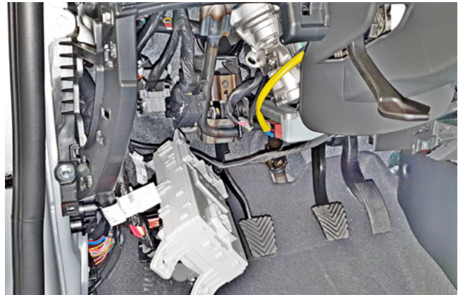
Фото 1.19. Монтажный блок предохранителей снят
