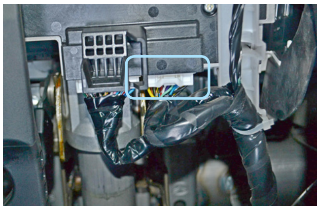
Фото 3.2. Местоположение разъёма блока SSU
