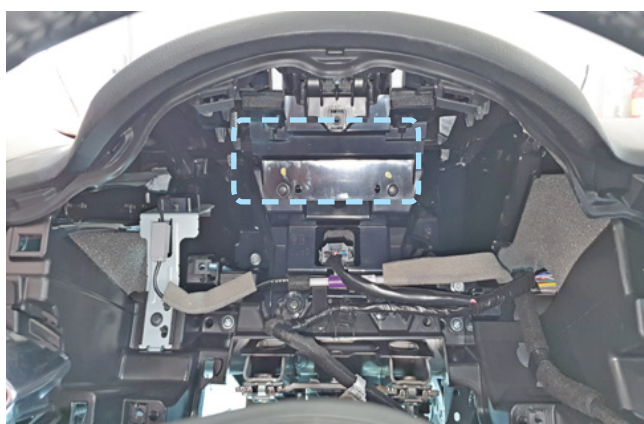
Фото 2.7. Пример расположения центрального блока охранно-телематического комплекса
