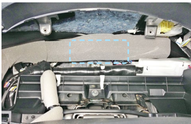
Фото 2.9. Пример расположения центрального блока охранно-телематического комплекса
