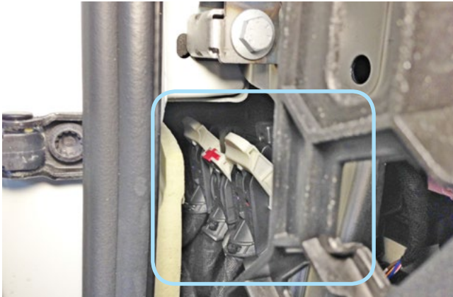
Фото 3.2. Местоположение блока BCM
