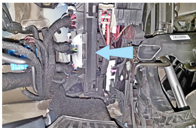
Фото 3.2. Местоположение блока BCM
