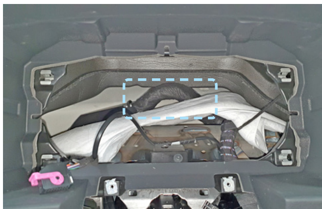
Фото 2.7. Пример расположения центрального блока охранно-телематического комплекса
