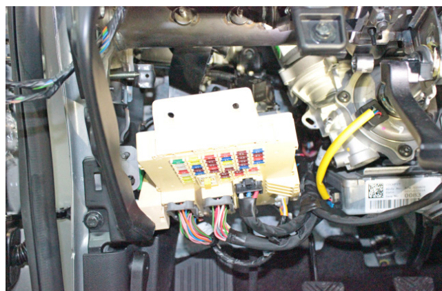
Фото 1.16. Монтажный блок снят
