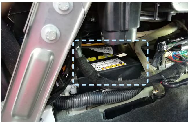
Фото 2.7. Пример расположения центрального блока охранно-телематического комплекса
