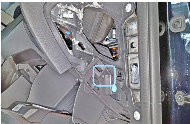
Фото 1.3. Боковая накладка снята. Саморез
