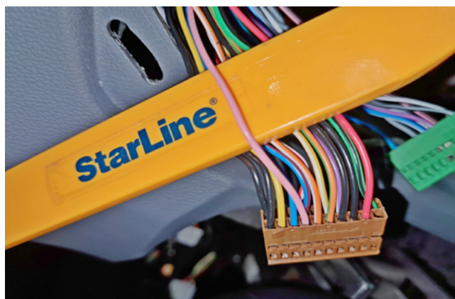
Фото 3.5. Контроль статуса «Генератор +» (розовый)
