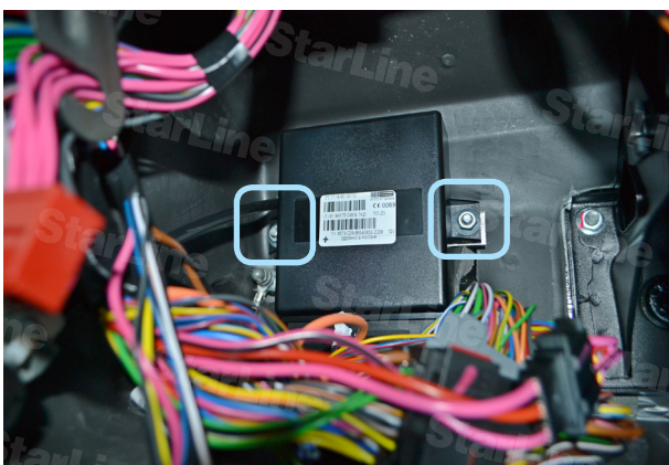
Фото 3.5. Гайки крепления блока штатной сигнализации
