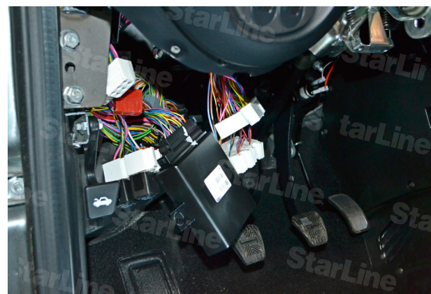
Фото 3.6. Блок штатной сигнализации снят
