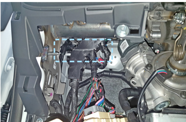
Фото 2.7. Пример расположения центрального блока охранно-телематического комплекса
