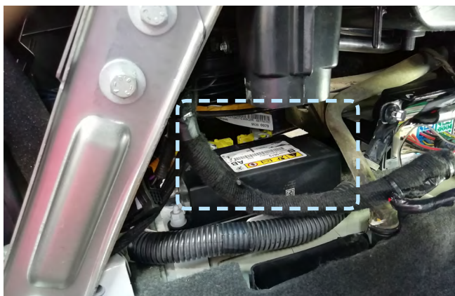
Фото 2.7. Пример расположения центрального блока охранно-телематического комплекса
