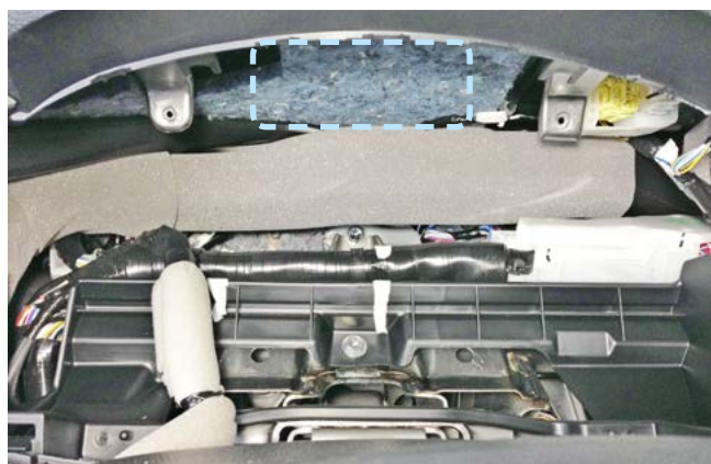
Фото 2.9. Пример расположения центрального блока охранно-телематического комплекса
