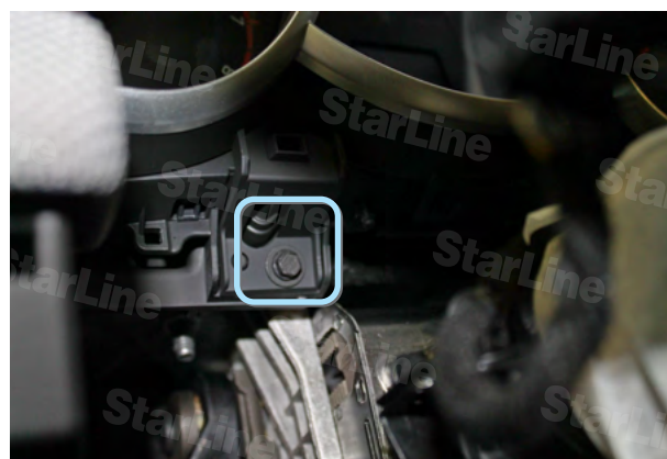
Фото 2.4. Нижняя накладка снята. Саморез крепления панели приборов слева
