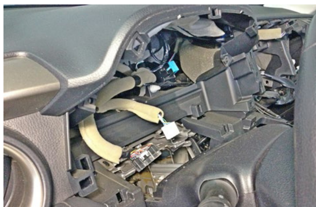
Фото 1.12. Панель приборов снята
