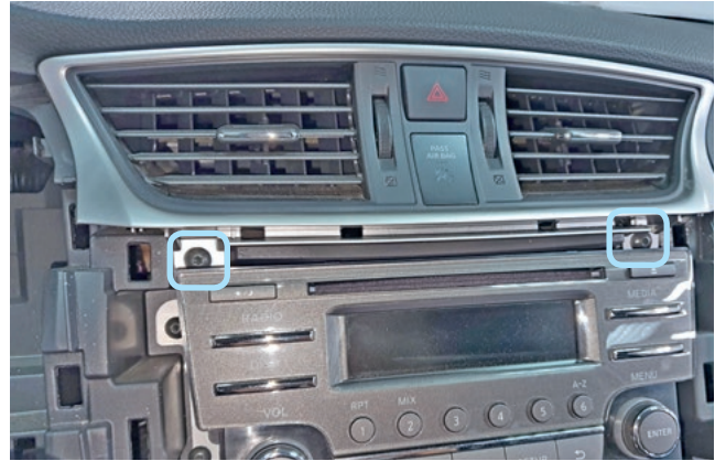
Фото 1.20. Саморезы крепления накладки центральных воздуховодов
