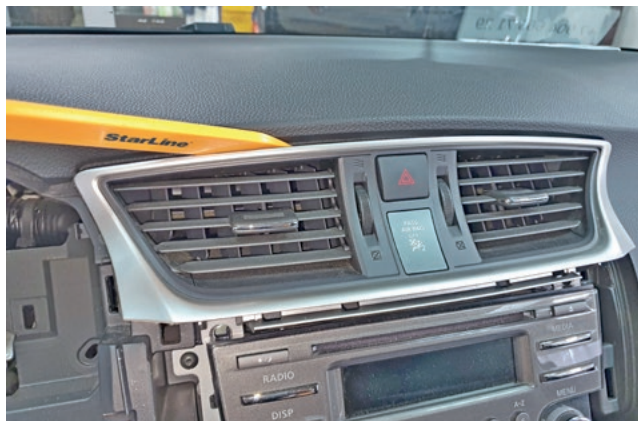
Фото 1.21. Снять накладку центральных воздуховодов
