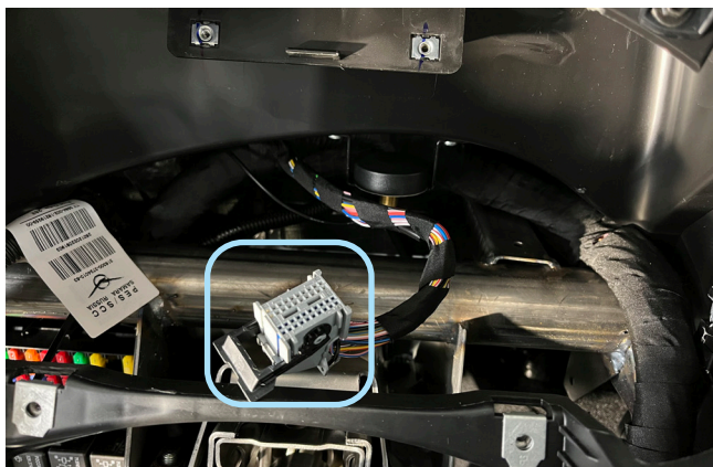
Фото 3.2. Местоположения разъёма приборной панели
