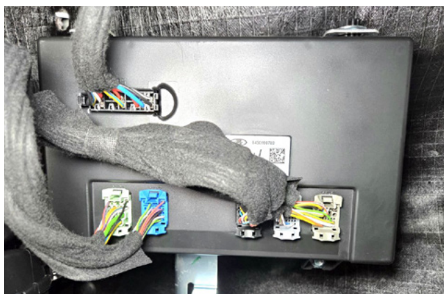
Фото 1.6. Блок BCM снят
