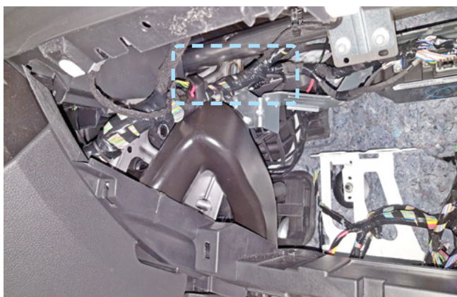
Фото 2.8. Пример расположения центрального блока охранно-телематического комплекса
