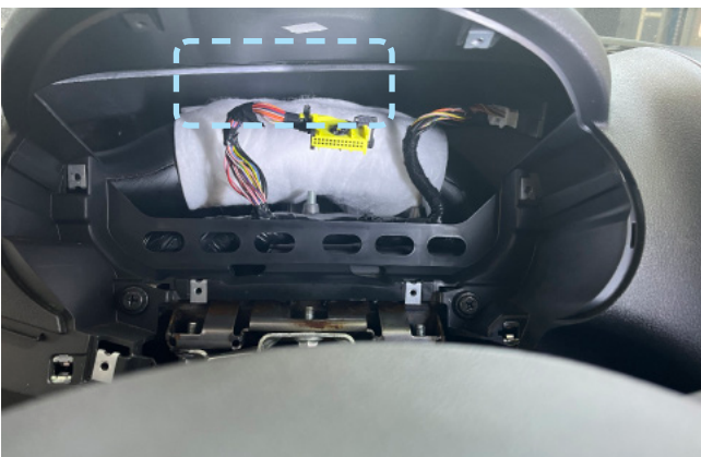
Фото 2.9. Пример расположения центрального блока охранно-телематического комплекса
