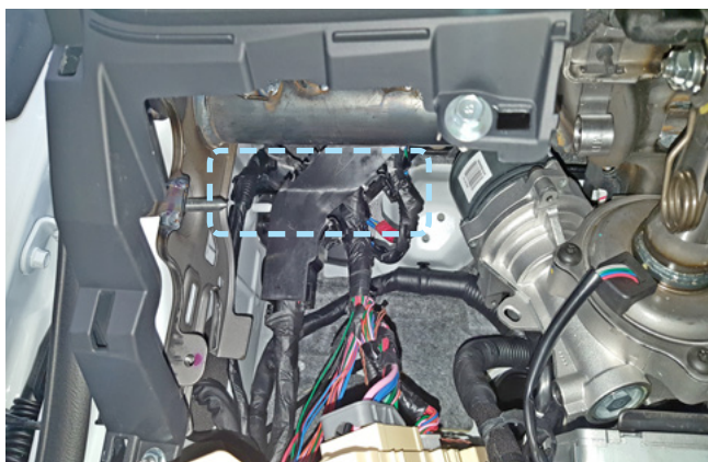
Фото 2.8. Пример расположения центрального блока охранно-телематического комплекса
