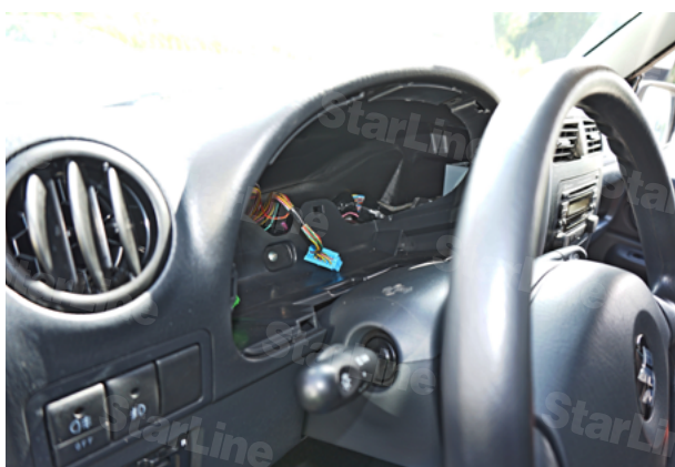
Фото 2.5. Панель приборов снята
